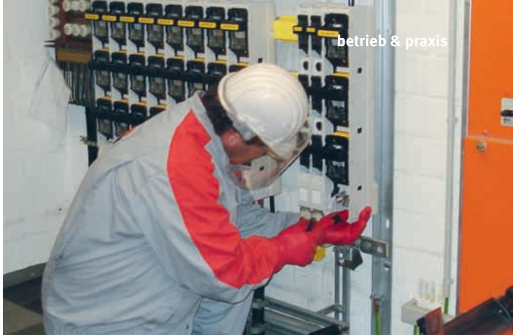
Bild 2: Einbau einer verriegelbaren NH-Sicherungsschaltleiste
