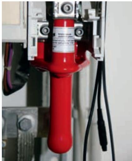
Bild 4: kurzgeschlossener Kabelanschluss in der Sicherungsschaltleiste
